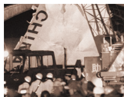
中華航空機墜落事故 (愛知県・旧名古屋空港) 平成6年4月26日 死亡者264名 出動 71社、415両
