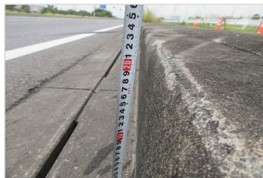
写真5—2 側道縁石高さ
