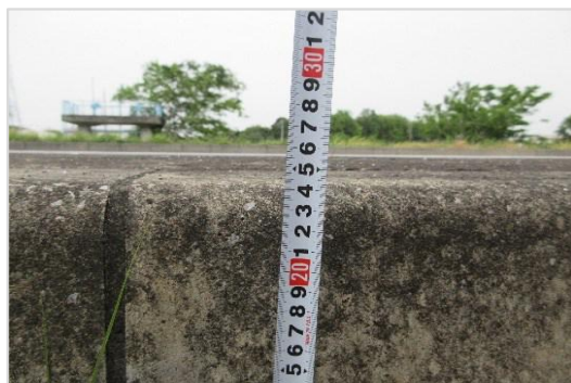
写真5—1 中央分離帯縁石高さ
